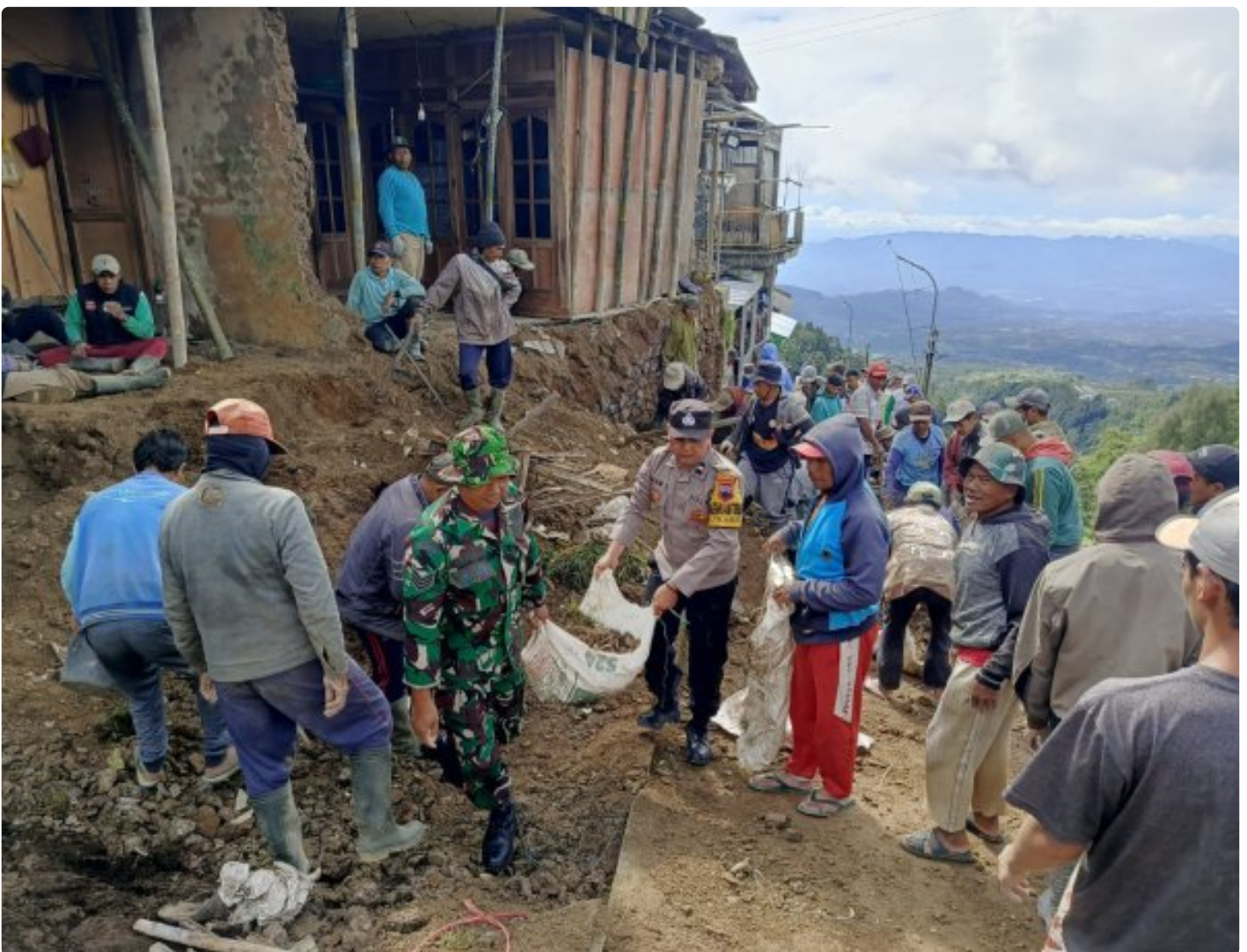
(Foto Dokumen) : Gotong royong pembersihan material longsor
